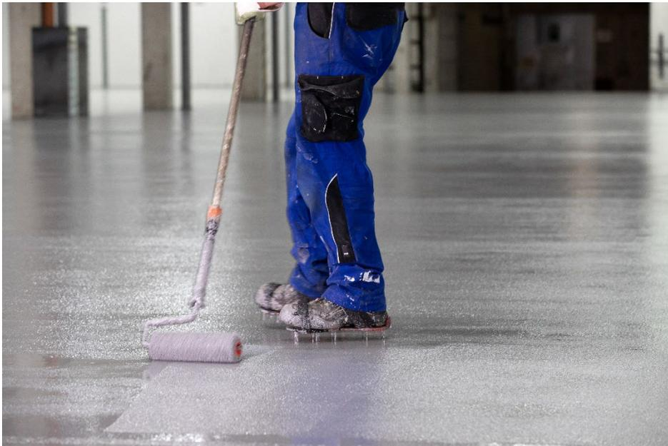
Die Hartkornbeschichtung Epoxy SIC Color ESD minimiert die Gefahr von elektrostatischen Personenaufładungen.
